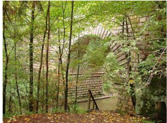
Kanalbrücke (Brückkanal) bei Feucht
