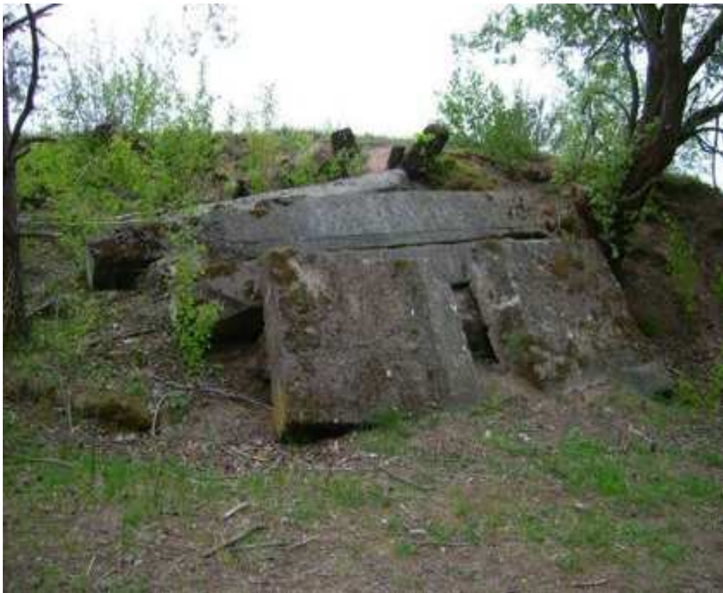
Diese Betontrümmer stammen wahrscheinlich noch aus Zeiten der Nutzung des Platzes durch die Deutschen
